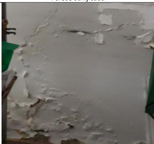
Parede danificada
